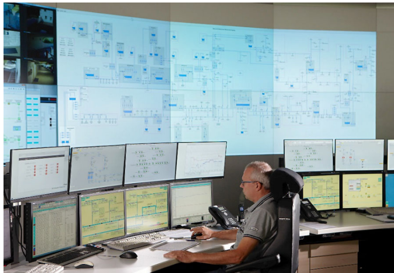
Abb. 4.4 Zentrale Leitstelle für die Überwachung und Steuerung wasserwirtschaftlicher Anlagen
