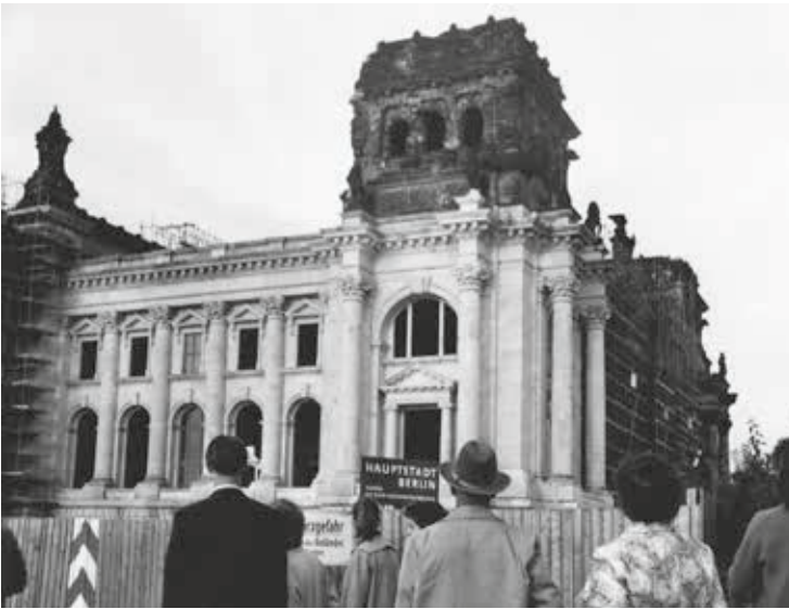
Federal Yapı Genel Müdürlüğü’nce 1958’de yapılan onarım sonrası Reichstag binasının ana cephesinin güney yarısına bir bakış.
