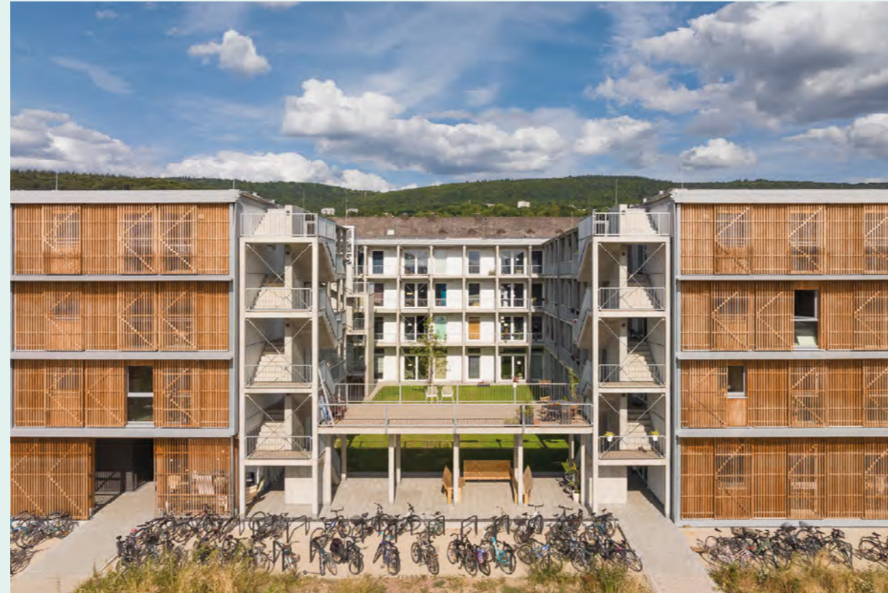
Abb. 120: Holzfassade des Neubaus mit Blick auf den Innenhof © Thilo Ross
