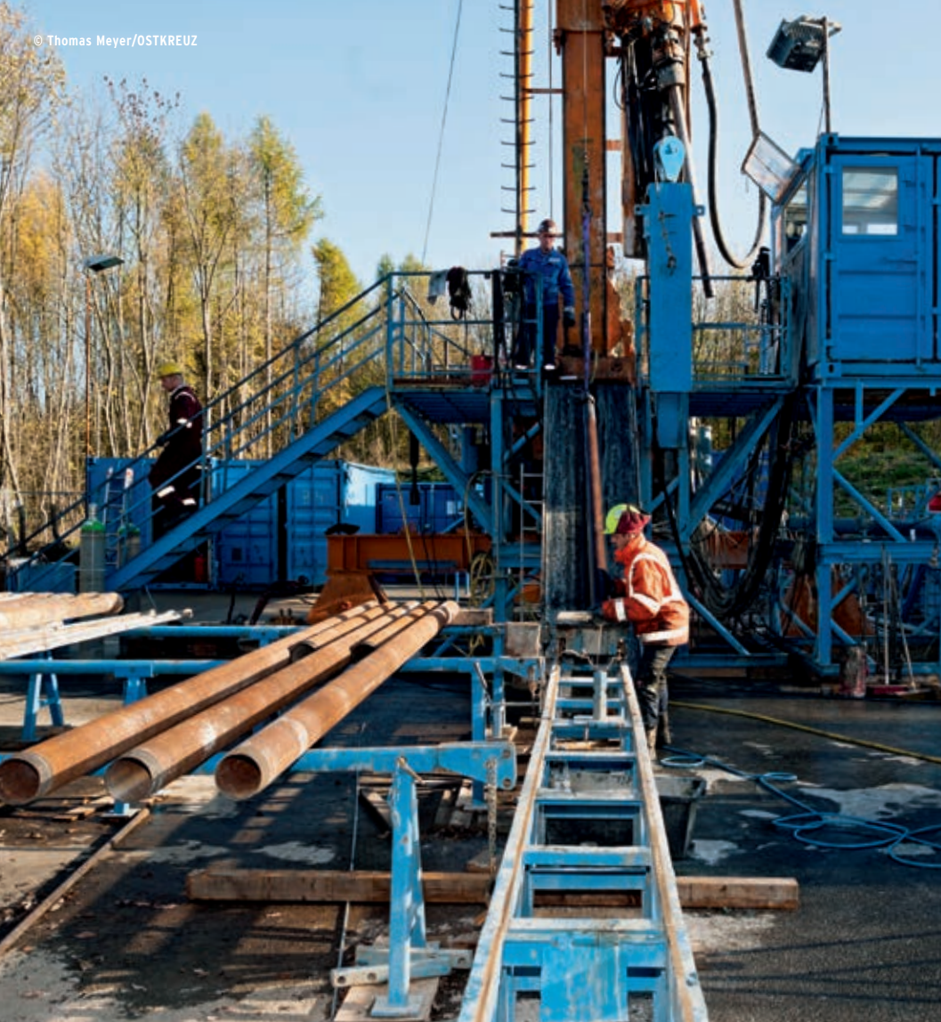
Erkundungsbohrung für den geplanten neuen Bergungsschacht Schacht 5
