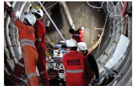
Geophysikalische In-situ-Messung, ausgehend von einer Tunnelwand
