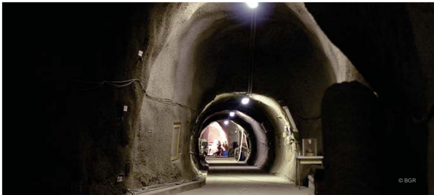
Sicherungsmaßnahmen (Spritzbeton und Ausbau) untertage im Tonstein
