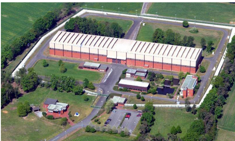
Abbildung G-2: Transportbehälterlager Ahaus (Bildrechte: GNS)
