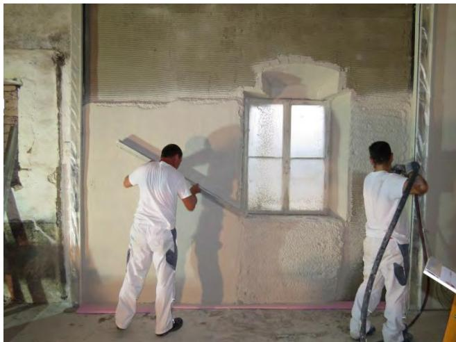
**Abb. 52 Fraunhofer-Zentrum für energetische Altbausanitize und Denkmalpflege Benedikt-beuern: An der wertvollen historischen Bausubstanz der »Alten Schäfflerei« im bayerischen Kloster Benediktbeuern werden innovative Materialien zur Innendämmung angebracht.**
