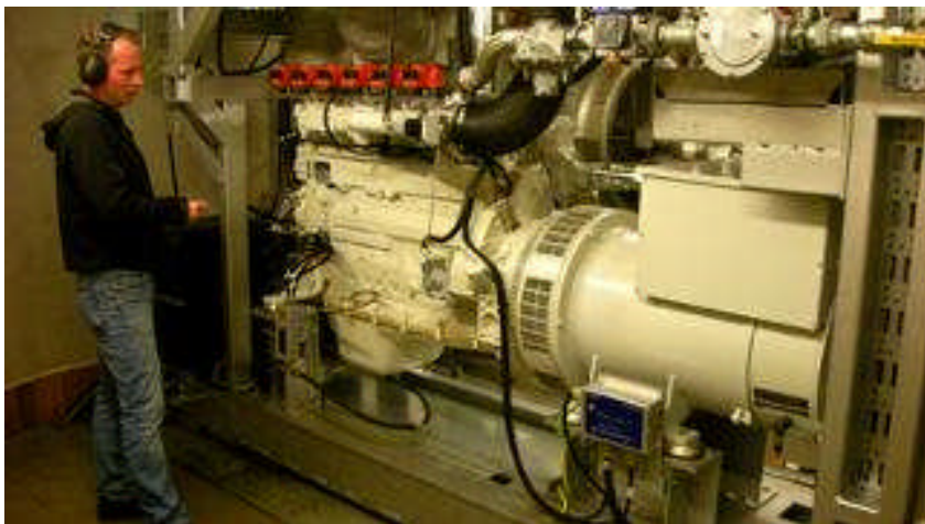
Blockheizkraftwerk
