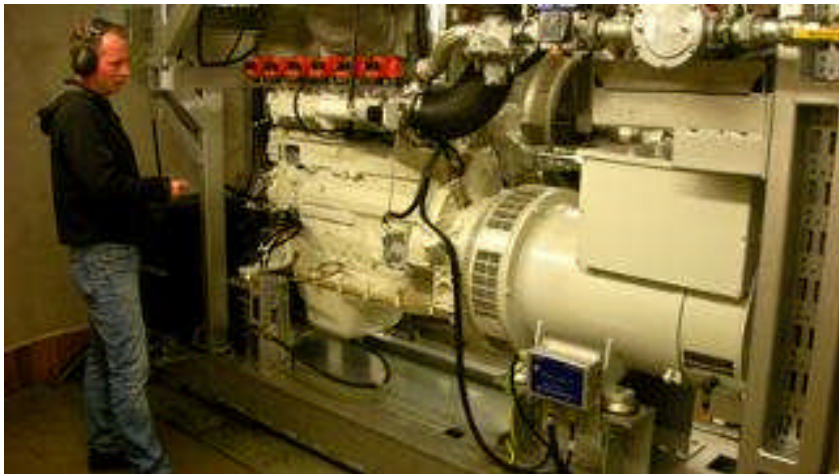
Blockheizkraftwerk
