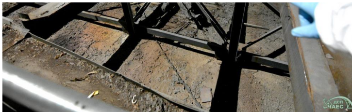
Abbildung 2 Abbruch der Metallabdeckung des Maschinenhauses im NSC mit Heckrotor eines 1986 auf das Maschinenhaus gestürzten Helikopters [Quelle: ChNPP, Dezember 2017]
