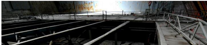
Abbildung 2 Abbruch der Metallabdeckung des Maschinenhauses im NSC mit Heckrotor eines 1986 auf das Maschinenhaus gestürzten Helikopters [Quelle: ChNPP, Dezember 2017]
