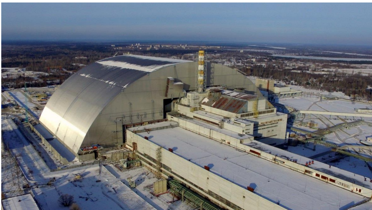
Abbildung 1 NSC nach der Verschiebung und Positionierung über dem Sarkophag Block 4 – Blick aus östlicher Richtung [Quelle: ChNPP, 2017]
