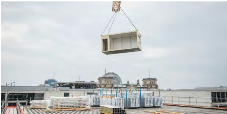
Il cantiere "Luisenblock West": un modulo viene portato sul cantiere con la gru.
