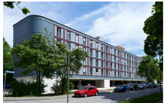
So geht's: Parkplatzüberbauung am Dantebad in München („Dante I“); Generalunternehmer: B&O
